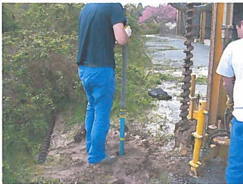
Figure n° 40 : Mise en place du piézomètre PZ3
