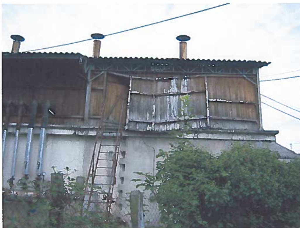
Figure n° 5 : Bardage dégradé
