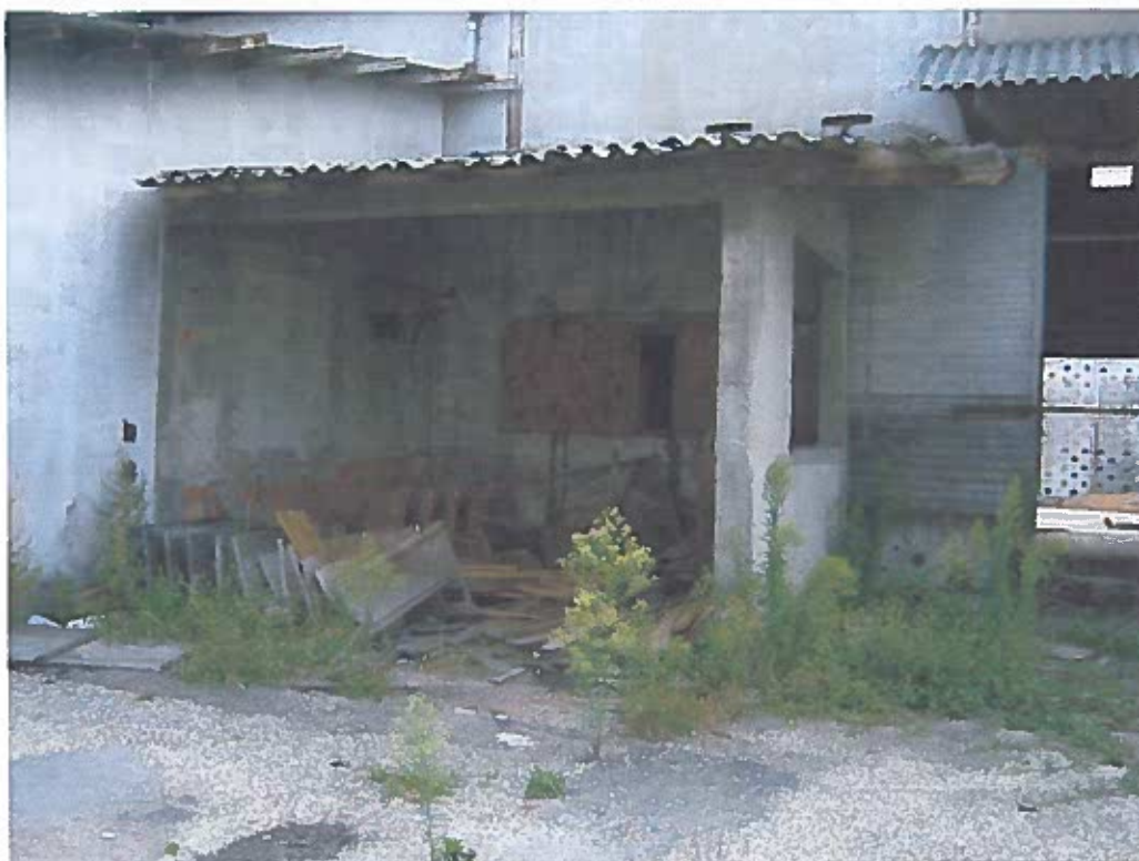
Figure n° 11 : Abri de l'ancien bac de traitement aux PCP
