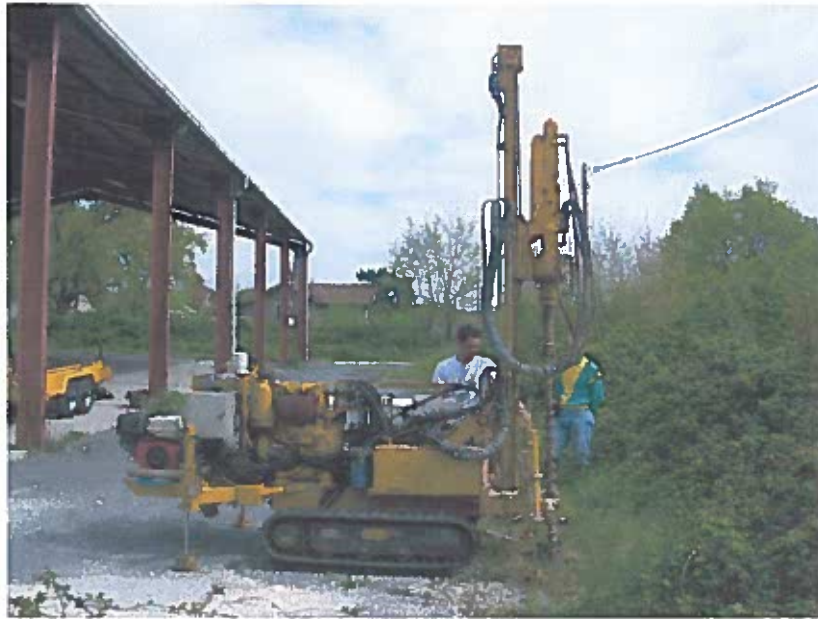
Figure n° 39 : Sondage à l'aide d'une sondeuse autotractée sur chenillettes
